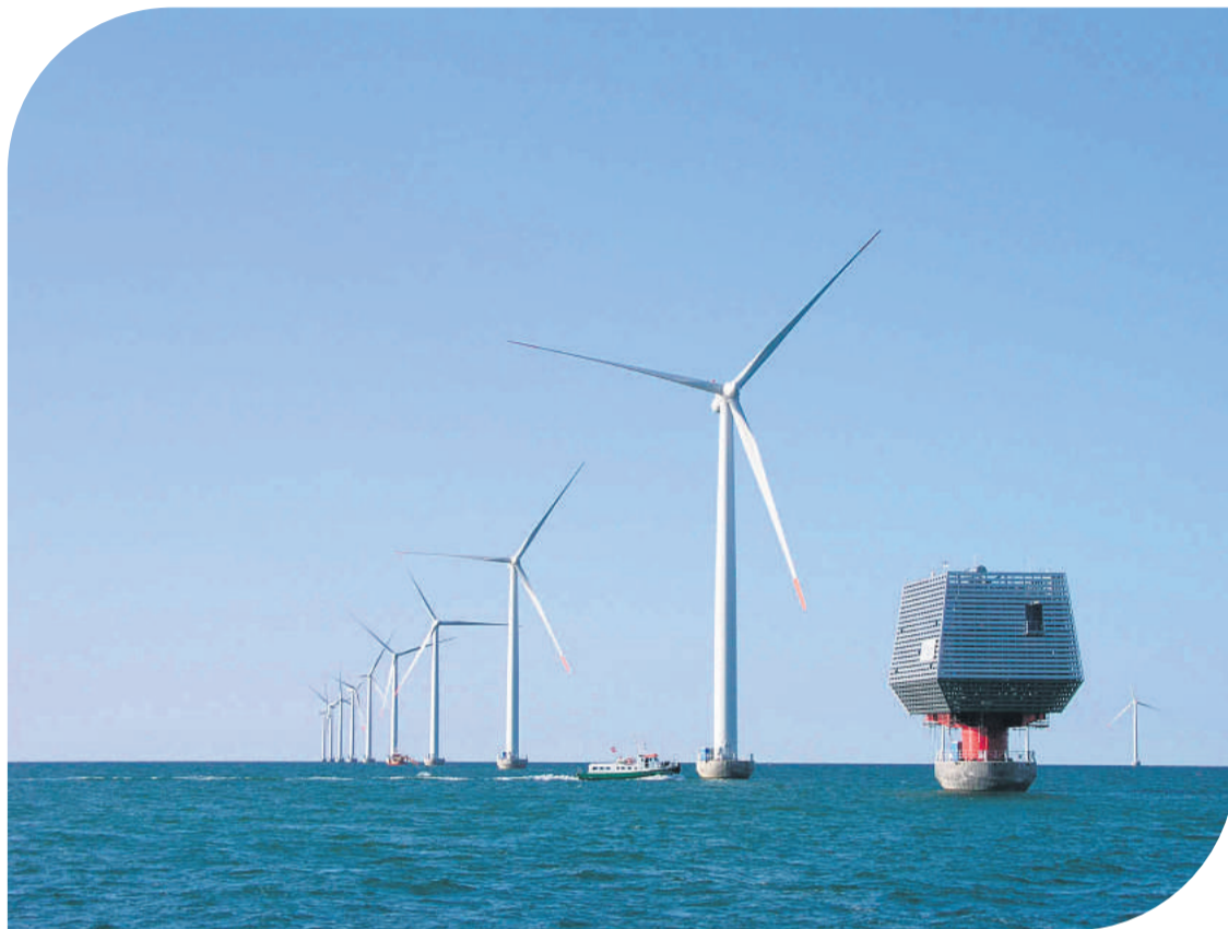
På billedet ses verdens første offshore substation i Nysted Havvindmøllepark. En substation er en afgørende del af en havvindmøllepark. Den sikrer, at strømmen når land, så den kan bruges i både husholdninger og virksomheder.
